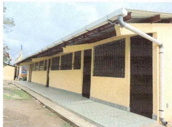
Foto 4: Cambio de canal de agua pluvial en anexo 3.
