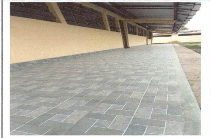
Foto1: Colocación de piso ceramico antideslizante en corredor anexo 2.
